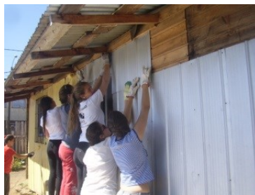
Construyendo en Lota, 2014.
